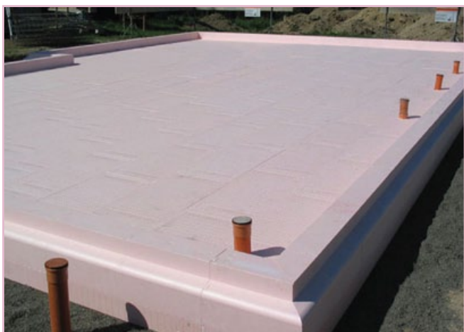
Εικ. 3 Μόνωση θεμελίων
