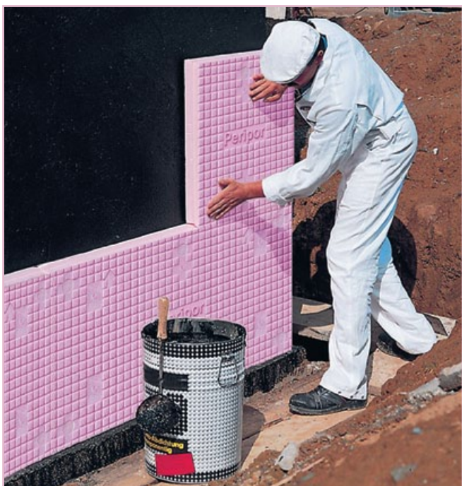
Εικ. 2 Μόνωση περιμετρικών υπόγειων τοιχείων
