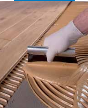
Άπλωμα της Ultrabond P990 1K
