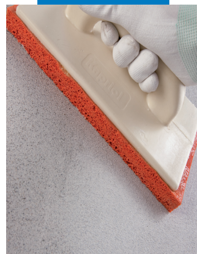
Φινίρισμα της εξομαλυντικής στρώσης με σπογγώδες τριβίδι
