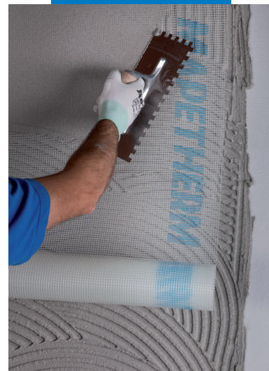
Εφαρμογή εξομαλυντικής στρώσης οπλισμένης με υαλόπλεγμα Mapetherm Net
