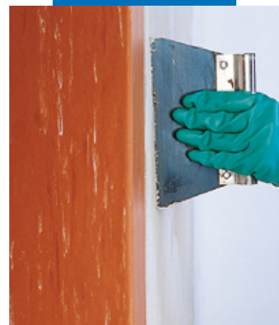
Stesura dell'adesivo dopo la posa del telo in PVC risvoltato sullo spigolo
