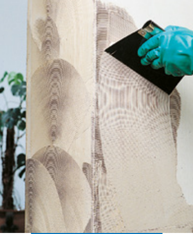
Stesura di Adesilex VS45 con spatola n. 1
