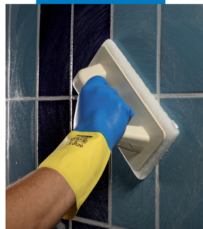
Το Κεραροxy CQ καθαρίζεται με νερό, χρησιμοποιώντας πατάκι Scotch-Brite®
