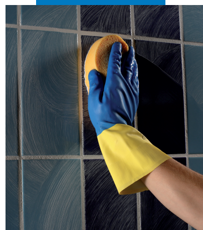
Καθαρισμός και τελείωμα με σκληρό σφουγγάρι κυτταρίνης
