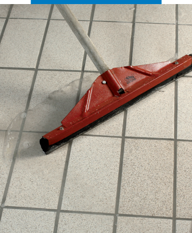
Απομάκρυνση περίσσειας υγρού με μάκτρο από καουτσούκ
